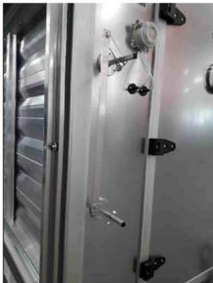
Obr. A – před demontáží pákového převodu
