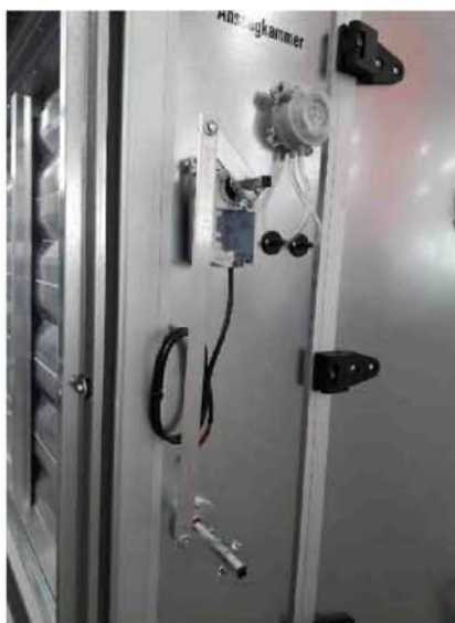
Obr. B – s namontovaným servopohonem
